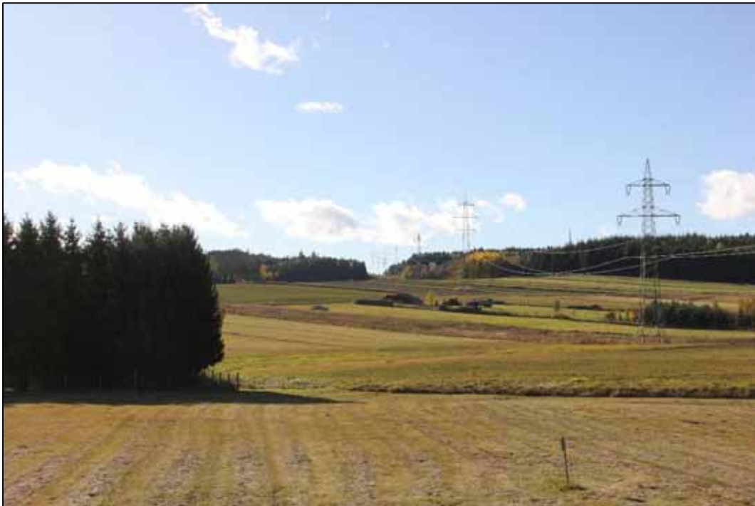
Foto 16: Blick Richtung Südwesten von der L8121 nördlich Neu-Dietmanns auf die 110 kV-Leitung. In der Geländesenke fließt der Siegheartser Bach.
