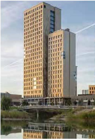
Das 84 m hohe Hoho in Wien besteht unter anderem aus Brettsperrholz-Wänden und Brettschichtholz-Stützen.
