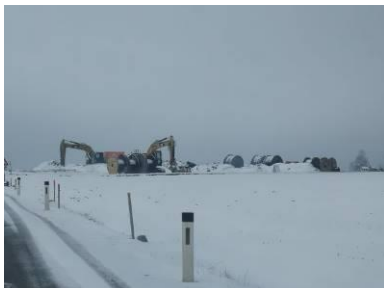
Abb.3.: Lagerplatz bei Baustelleneinfahrt zu Windpark Grafenschlag II. Geschlossene Schneedecke und wolkenverhangener Himmel (Datum: 14. April 2021).
