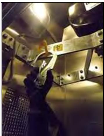
2. Drücken Sie manuell den Notriegelungsknopf des Türkontaktschalters (innerhalb oder außerhalb des Aufzugs).
