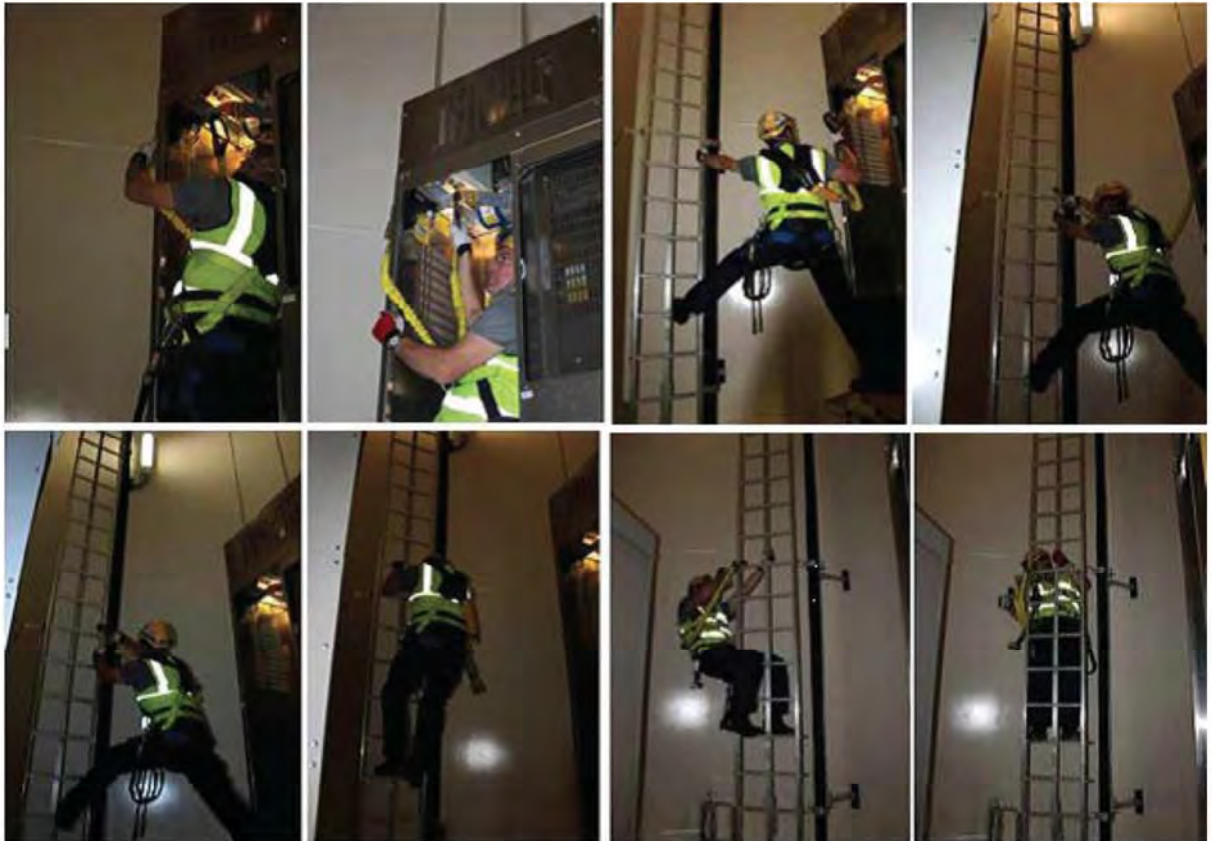
Abbildung 7.24: Ablauf für die Evakuierung aus dem Serviceaufzug
