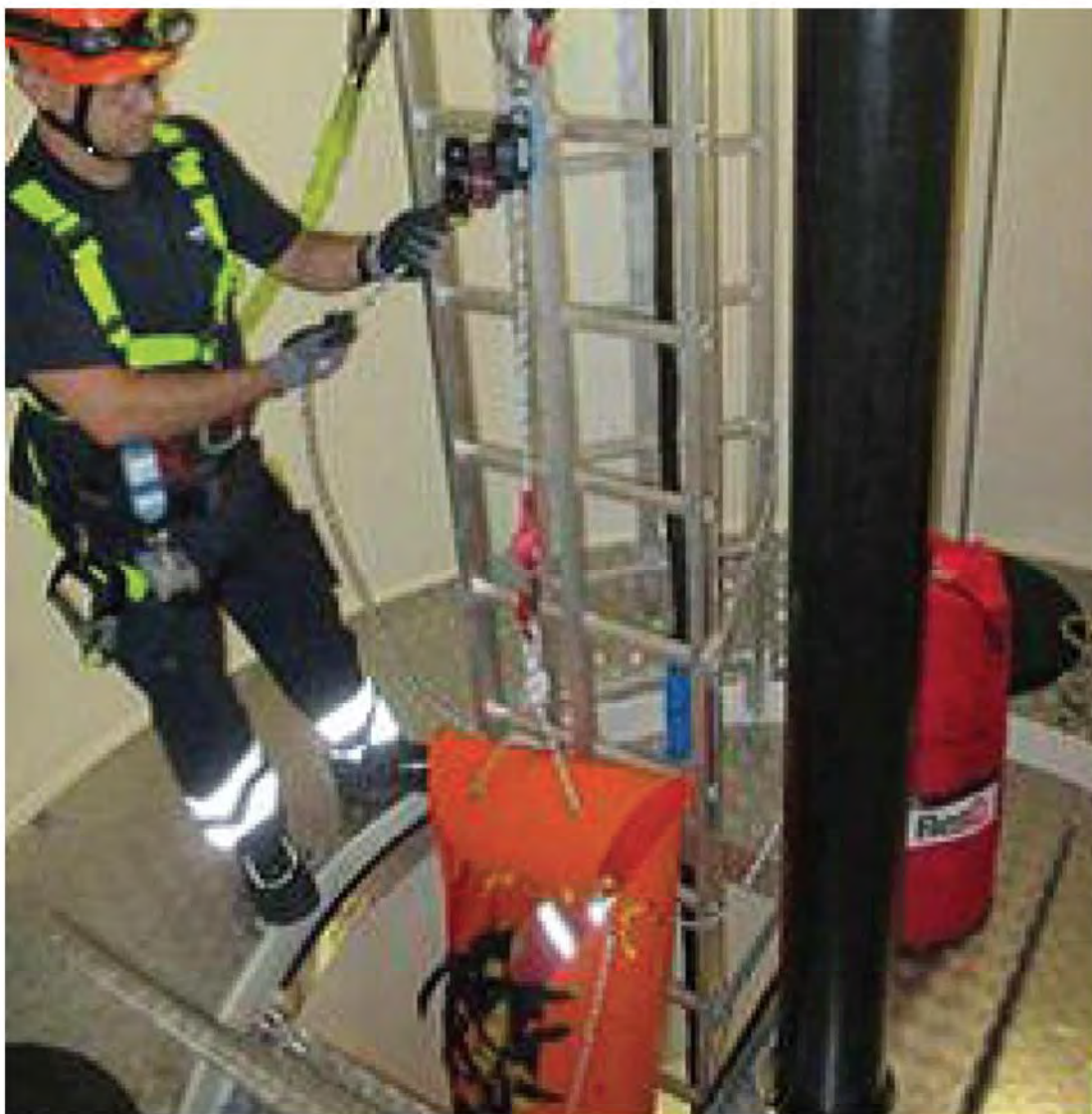
Abbildung 7.22: Die Person beim Absenken führen, wenn die Abstiegsvorrichtung verwendet wird
