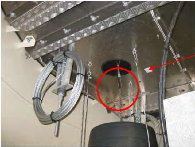
Abbildung 22: Abdichtungsmaßnahmen im Bereich der Kabeldurchführungen, hier Servicelift Versorgungskabel
