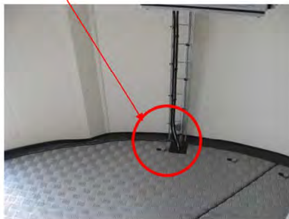
Abbildung 20: Abdichtungsmaßnahmen im Bereich der Kabeldurchführungen, hier SCADA Hilfschrank
