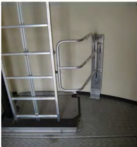
Abbildung 19: Abdichtungsmaßnahmen im Bereich der Durchstiegs Luke
