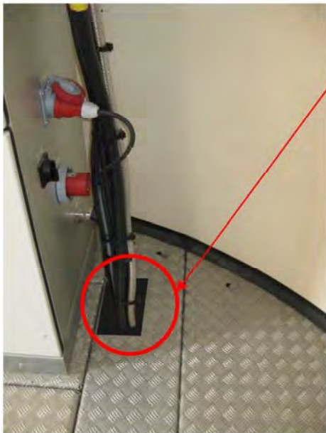
Abbildung 21: Abdichtungsmaßnahmen im Turmeingangsbereich, Steuerschrank
