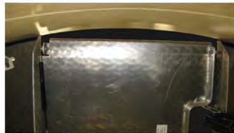
Abbildung 18: Abdichtungsmaßnahmen im Bereich der Durchstiegs Luke, von unten gesehen
