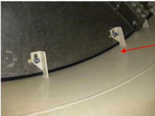
Abbildung 24: Abdichtungsmaßnahmen im Anschluss bei Turminnenwand, von unten
