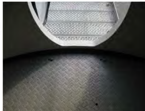
Abbildung 23: Abdichtungsmaßnahmen im Anschlussbereich Plattform – Turminnenwand, von oben
