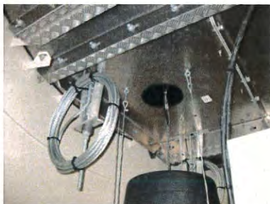
Abbildung 10: Abdichtungen im Bereich der Kabeldurchführungen
