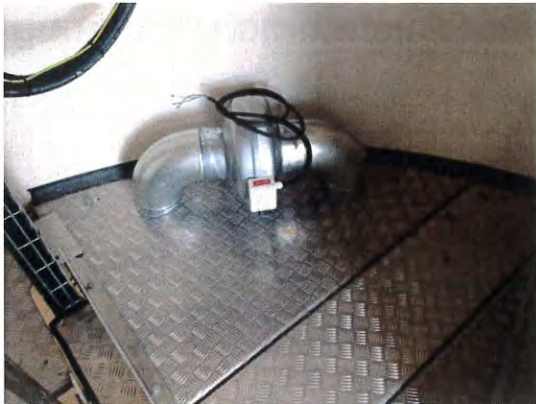
Abbildung 7: Durchstieg in den Keller links, Lüfter im Vordergrund
