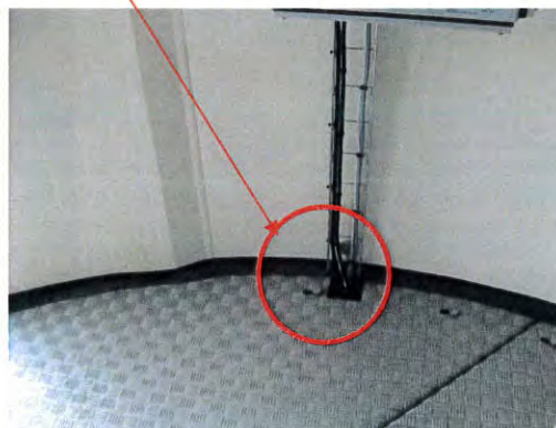
Abbildung 20: Abdichtungsmaßnahmen im Bereich der Kabeldurchführungen, hier SCADA Hilfschrank
