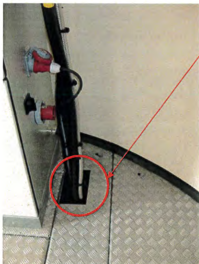
Abbildung 21: Abdichtungsmaßnahmen im Turmeingangsbereich, Steuerschrank
