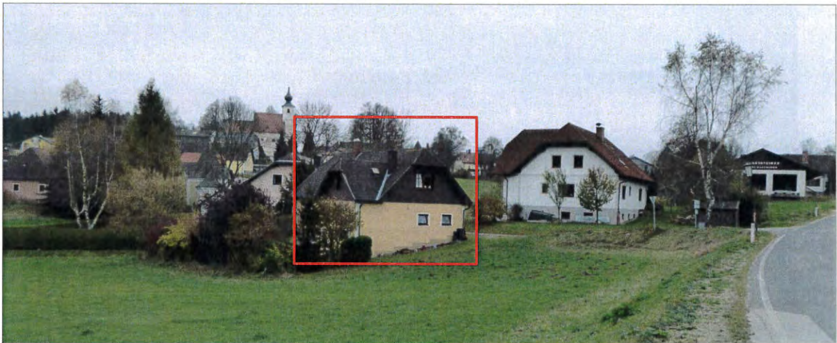
Abb. 8: IP A - Foto des Wohnhauses (Aufnahmerichtung von den geplanten Anlagen aus)
