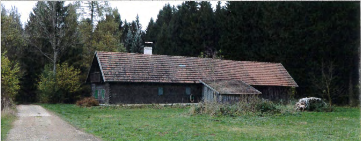
Abb. 17: IP D - Foto des Waldarbeiterhauses (Aufnahmerichtung von den geplanten Anlagen aus)
