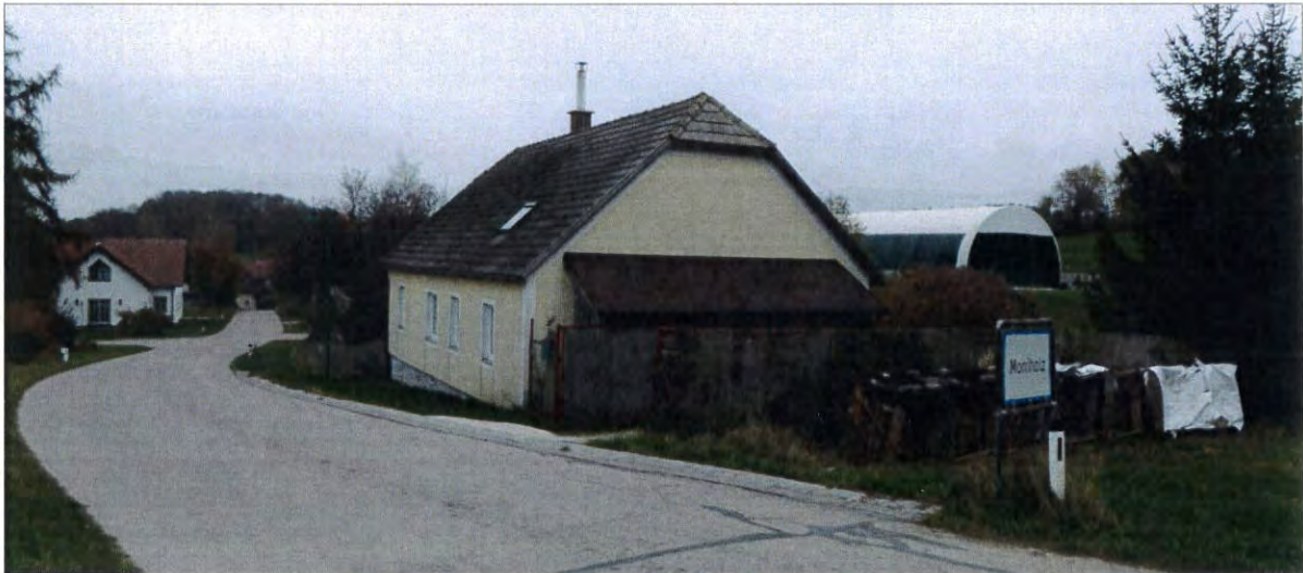
Abb. 11: IP B - Foto des Wohnhauses (Aufnahmerichtung von den geplanten Anlagen aus)
