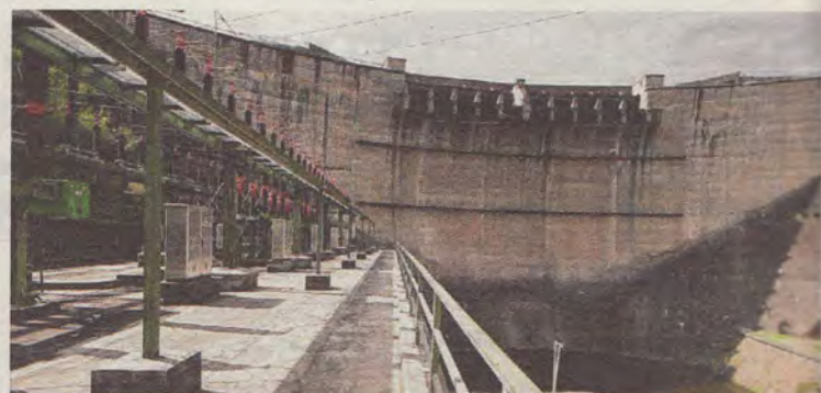
Erster Schritt: Der Strom aus dem Kampkraftwerk Ottenstein wird auf direkter Leitung nach Theiß gebracht.
