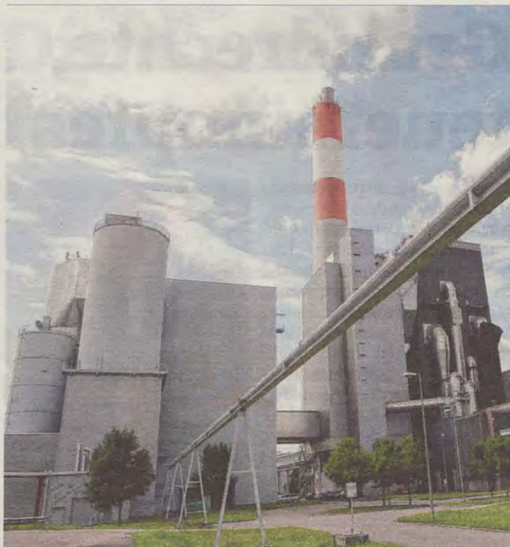
Das Gaskraftwerk Theiß ist das Herzstück der niederösterreichischen Stromversorgung im Notfall.
