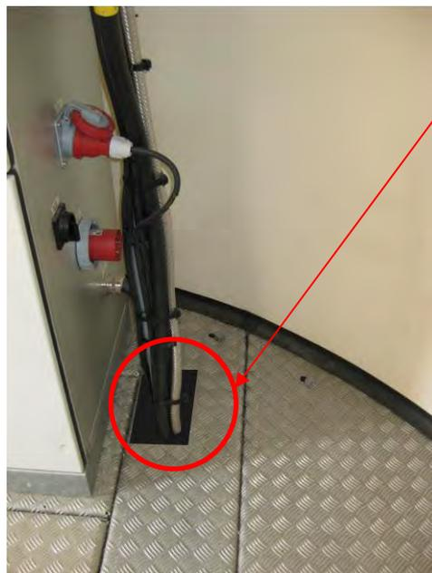
Abbildung 21: Abdichtungsmaßnahmen im Turmeingangsbereich, Steuerschrank
