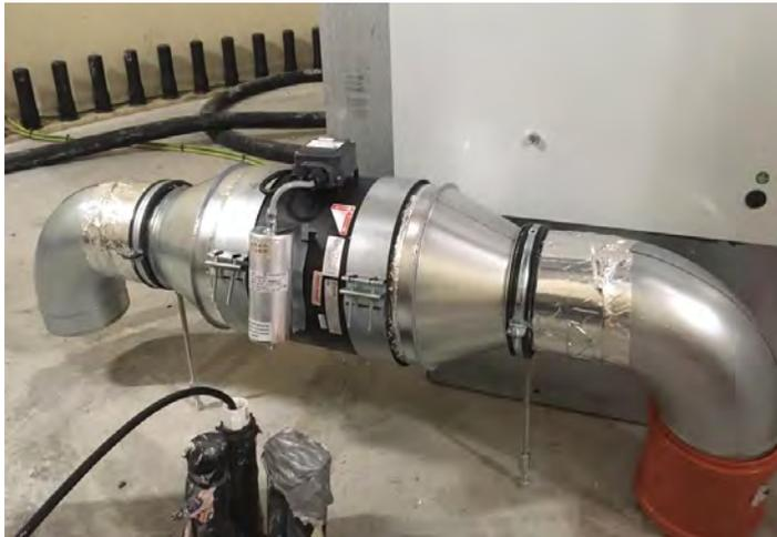
Abbildung 74: Axiallüfter mit Ansaug- und Druckrohr im Turmkeller neben Schaltanlage
