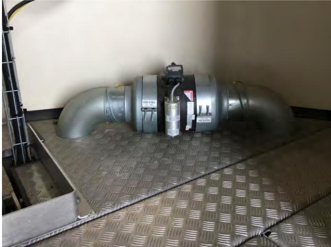
Abbildung 75: Turmeingangsplattform mit Durchstieg zum Kellerraum. Schematisch dargestellt der Axiallüfter mit Ansaug- und Druckrohr, beispielhaft für einen Standardturm
