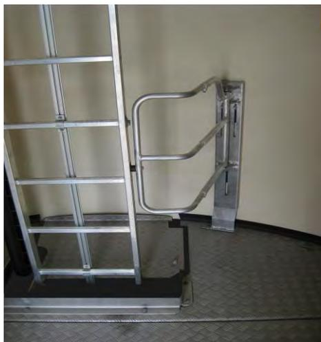
Abbildung 19: Abdichtungsmaßnahmen im Bereich der Durchstiegs Luke
