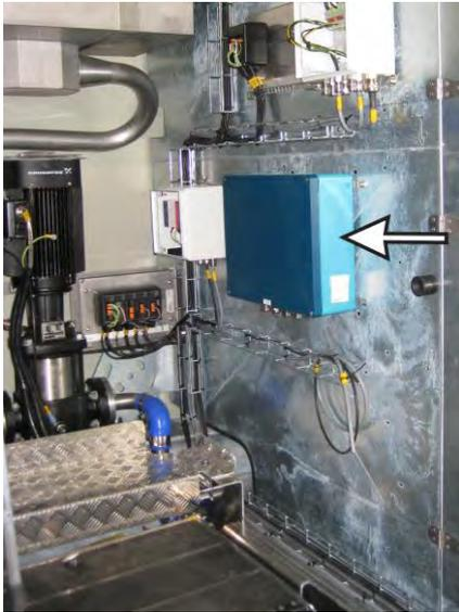
Abbildung 65: Steuerungseinheit der Flugbefuerung im Steuer-schrank im Maschinenhaus
