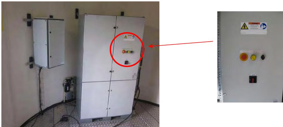
Abbildung 9: Darstellung des Steuer-Schaltschranks auf der Eingangsplattform des Turms
