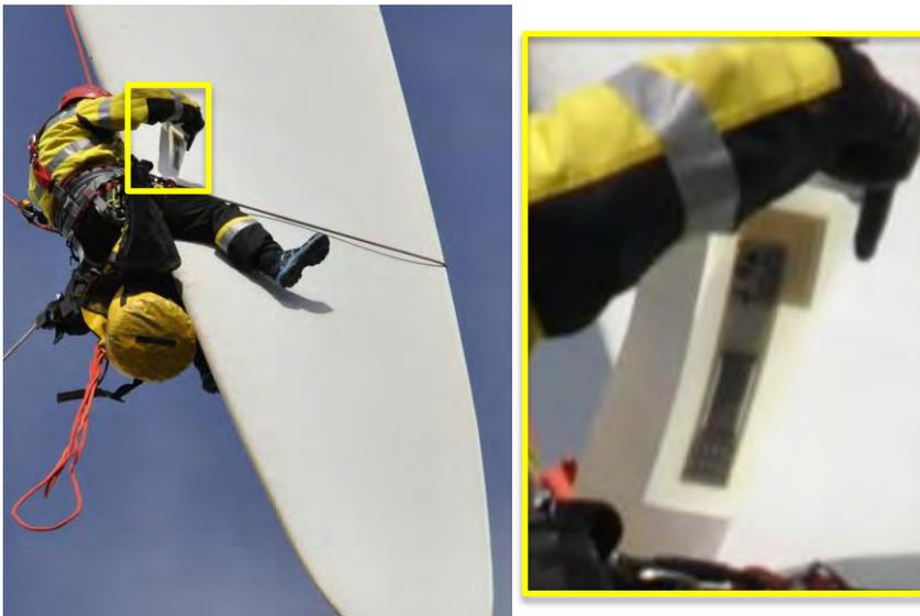
Bild 4 Sensormontage im Retrofit
