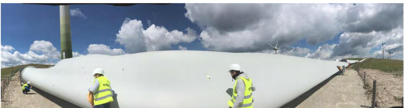
Bild 6 Montage der Sensoren am Boden
