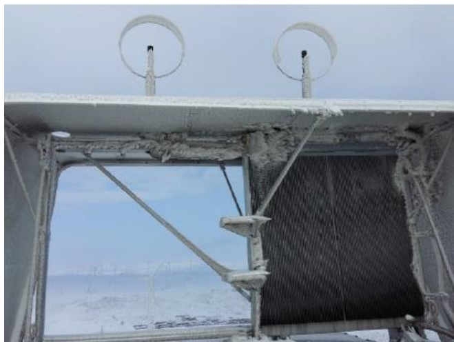
Abbildung 7-2: Ansammlung von Eis auf dem Rotorblatt und Cooler Top®
