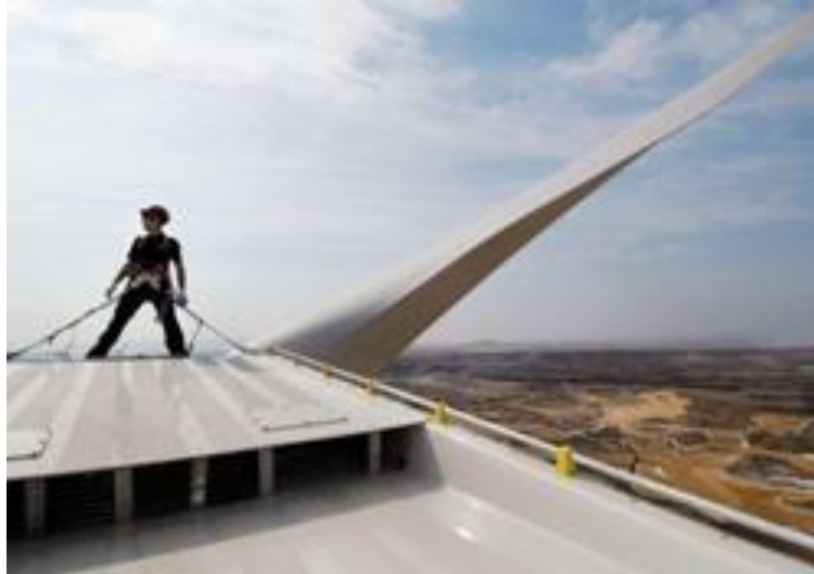
Abbildung 11-1: Arbeiten auf dem Maschinenhaus
