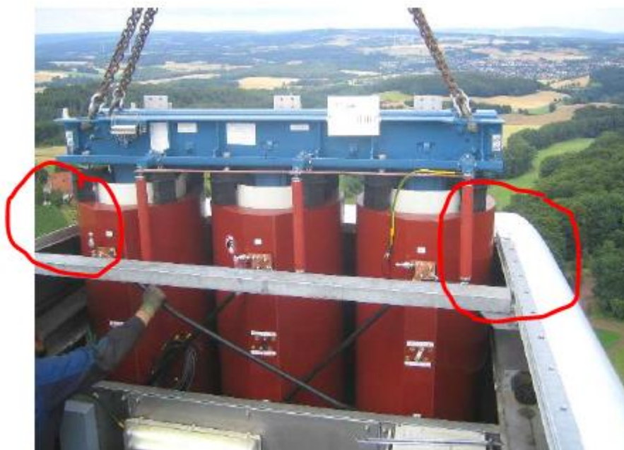
Abbildung 19-1: Führen des Transformators in das Maschinenhaus
