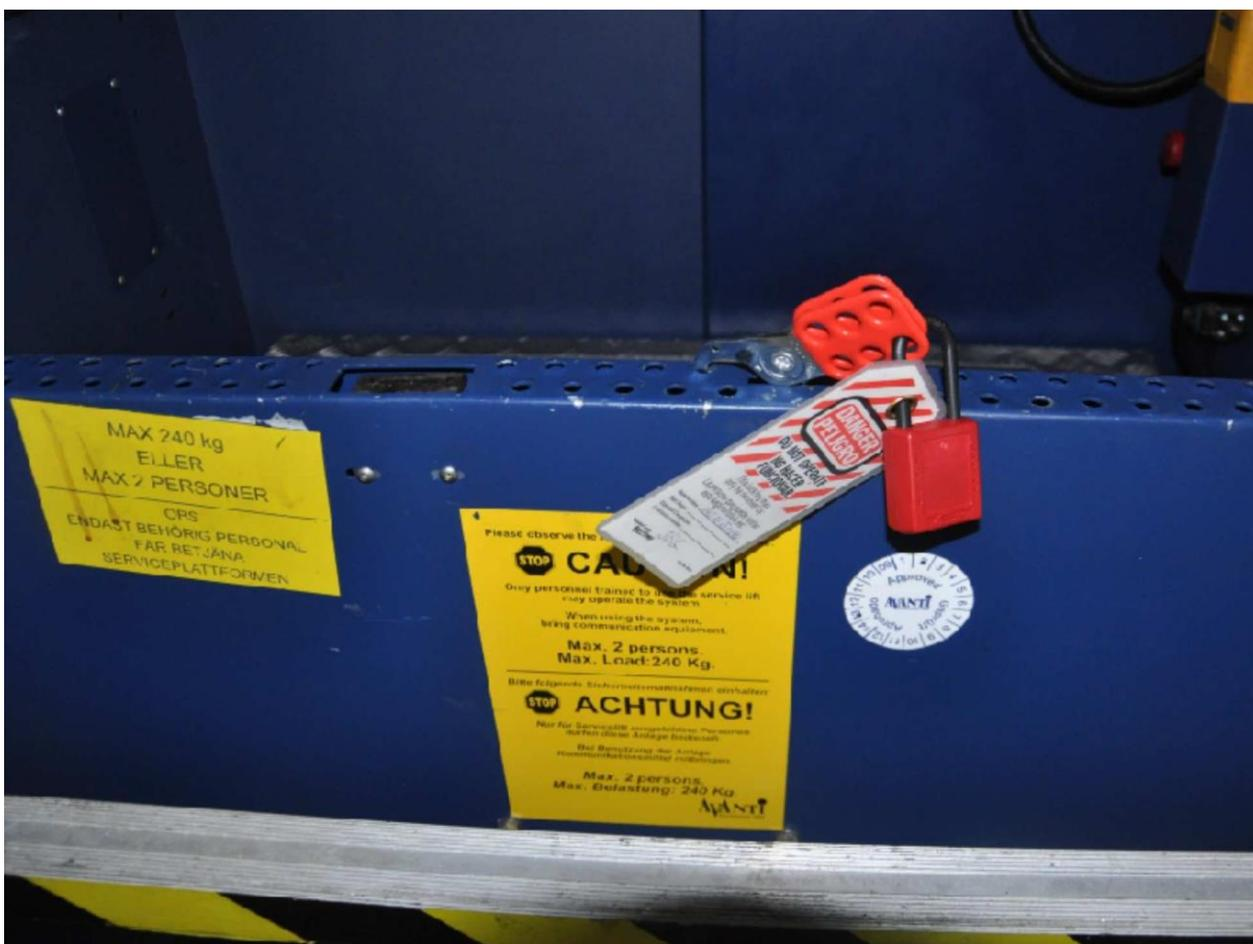
Abbildung 17.4: Serviceaufzug gesperrt
