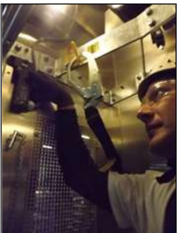
3. Verbinden Sie den zweiten Sicherheitshaken mit der Einhängeöse an der Außenseite des Aufzugs. Lösen Sie dann den Haken von der Einhängeöse in der Kabine und haken Sie sich an einem der Sicherheitsankerpunkte an der Leiter ein.
