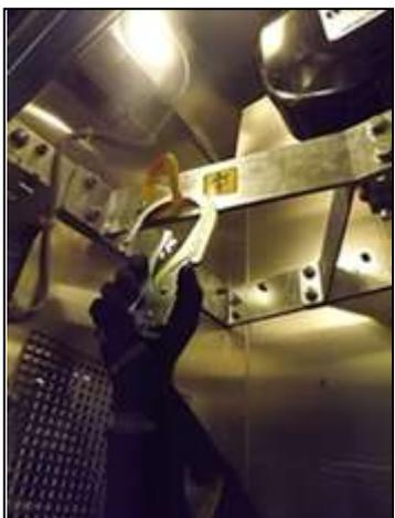
2. Drücken Sie manuell den Notentriegelungsknopf des Türkontaktschalters (innerhalb oder außerhalb des Aufzugs).
