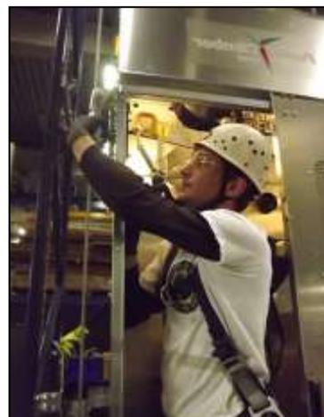
4. Lösen Sie den Sicherheitshaken an der Außenseite des Aufzugs und befestigen Sie ihn ebenfalls an einem der Sicherheitsankerpunkte an der Leiter.
